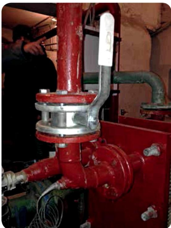
КОНТУР ГВС ПОСЛЕ ПЛАСТИНЧАТОГО ТЕПЛООБМЕННИКА
